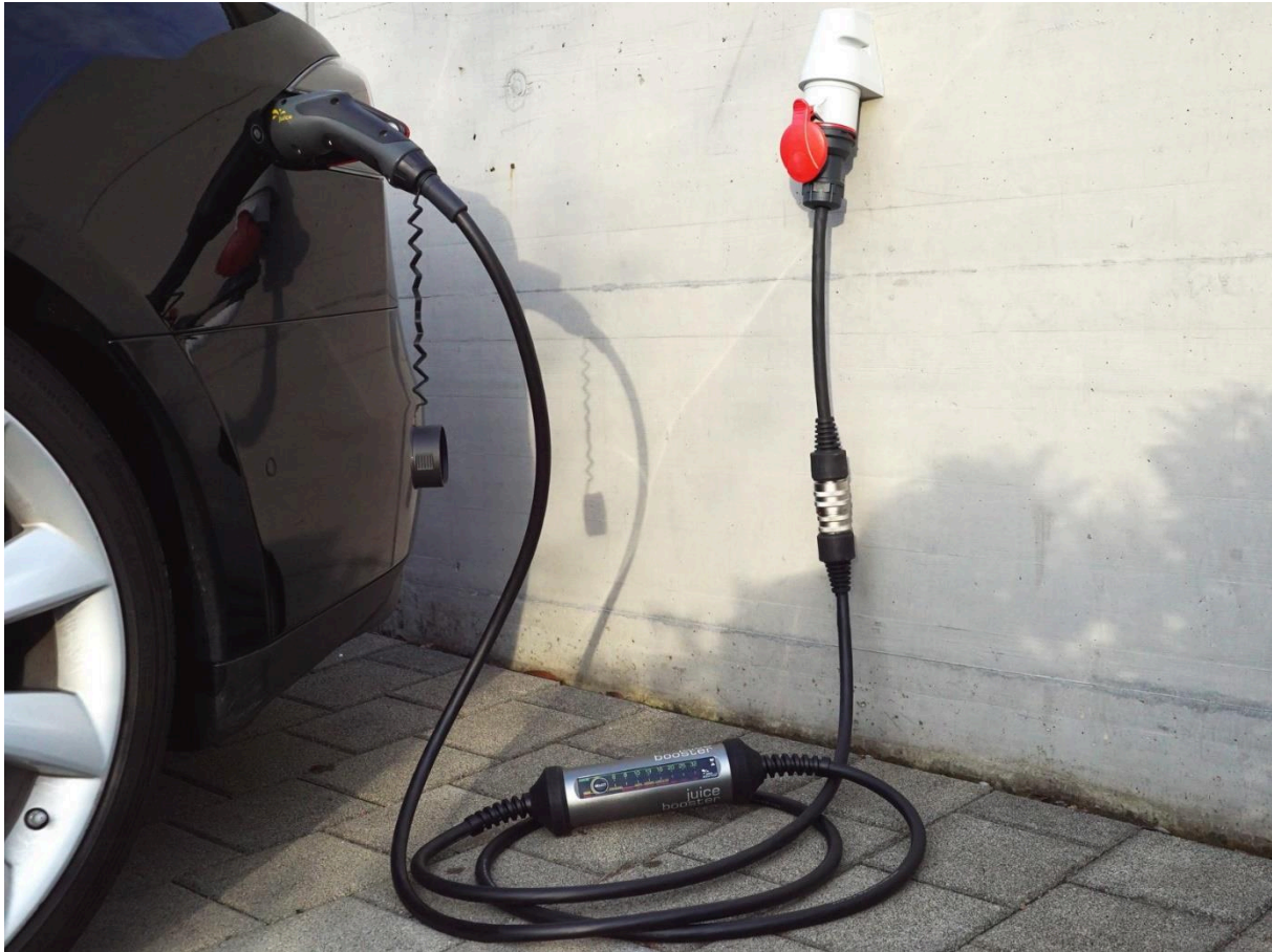
Beispiel einer mobilen Ladestation: der Juice Booster 2 an einer roten CEE Industriesteckdose. (Bildquelle: Juice Technology).
